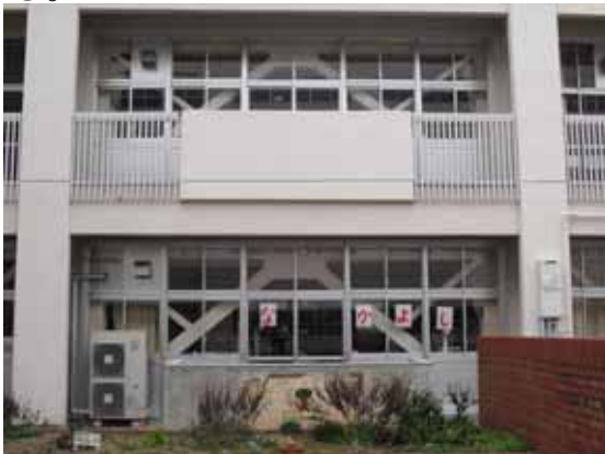
耐震補強実施状況
