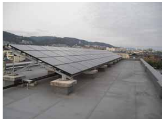
太陽光パネル設置状況
