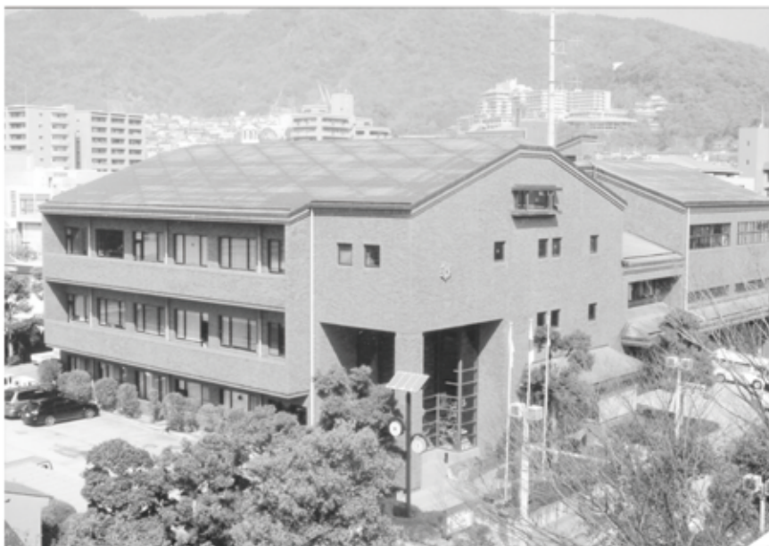
箕面市消防本部・箕面消防署
