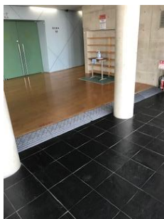
スカイアリーナ 段差解消のプレート敷設
