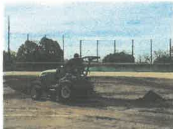
野球場重整備(武道館)
