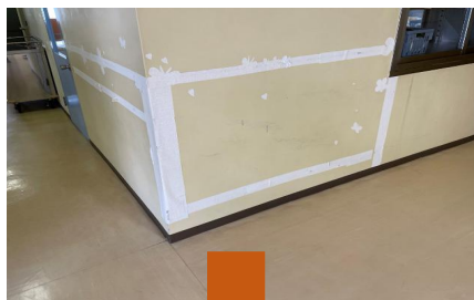
廊下等の壁の修繕
