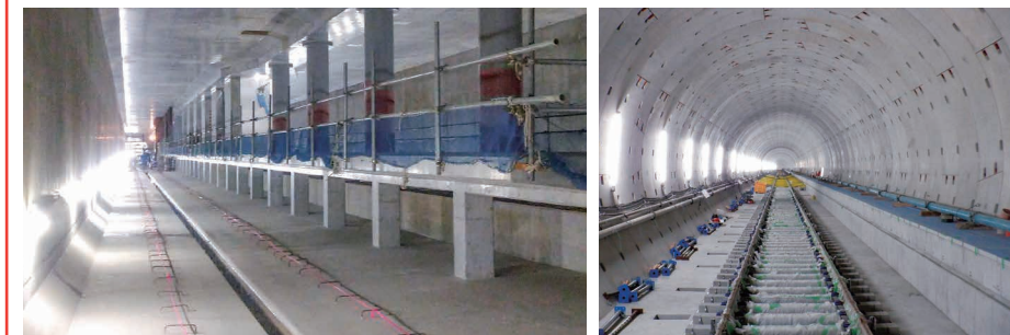
鉄筋コンクリートの構造物がほぼ完成した箕面船場阪大前駅 令和2年に完成したシールドトンネル内でのレール敷設工事
