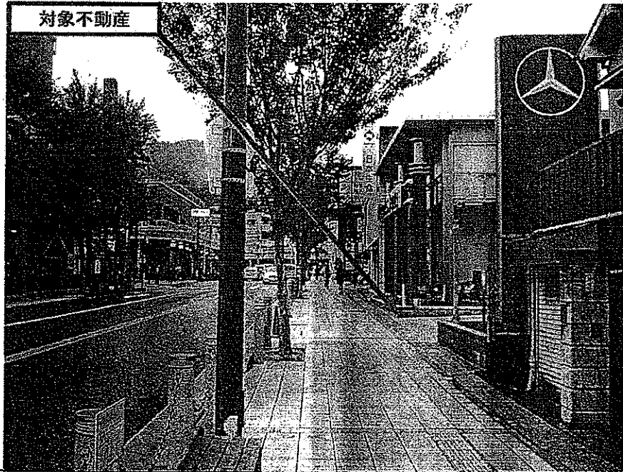
対象不動産を南側より撮影(西側接面道路)
