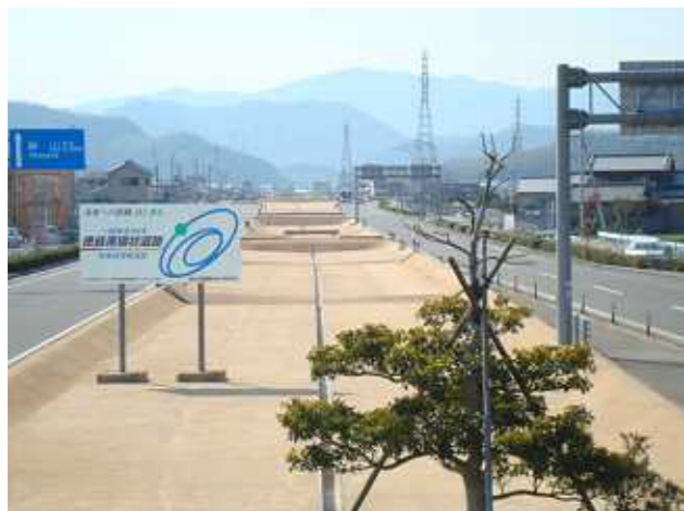
中央分離帯に土を固めた舗装を行い、防草対策を施した事例 （徳島県南環状道路）
