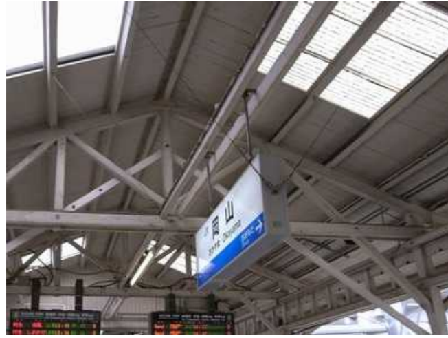
波型ポリカによる上屋の採光事例 (JR岡山駅ホーム)
