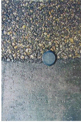
舗装仕上げ比較イメージ 現況AS舗装 改修自然色AS舗装
