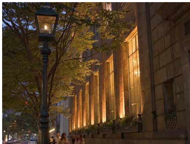
神戸市旧居留地 38 番館の街路のガス燈
