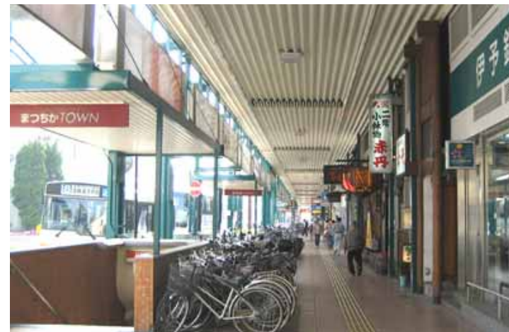
改修した駅前アーケード
