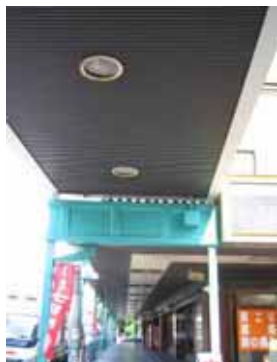
サンプラザ1、2号館間アーケード
