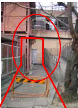
商店街側（西側）への歩行者用出入口の新設（駐輪場建替時）
