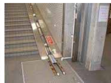
オートスロープ（サイクルコンベアー）の設置例（建替時）
