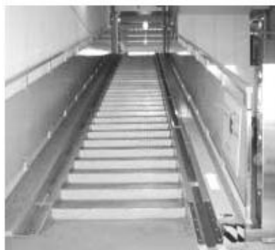
オートスロープ（サイクルコンベアー）の設置例（建替時）
