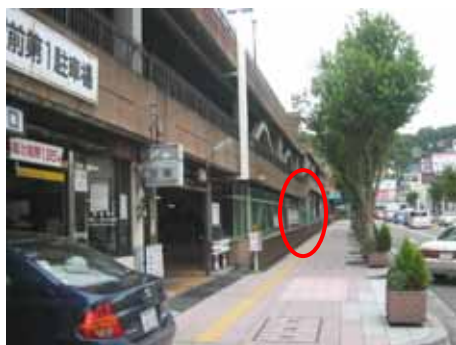
シンボルロード側（東側）への歩行者用出入口新設
