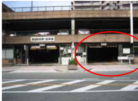
出口（料金精算所）の改修
