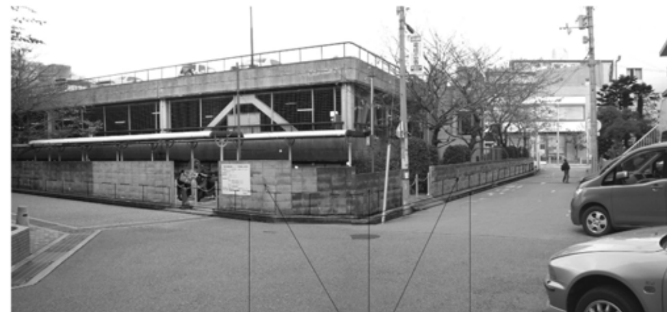
側溝（グレーチング設置） ブロック壁を撤去し、デザインフェンスに変更 側溝（グレーチング設置）
