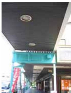
サンプラザ1、2号館間アーケード
