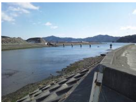
(写真③)大槌川の河口(奥側)。大槌川を遡上した津波は堤防を越えて市街地(右側)を襲った。
