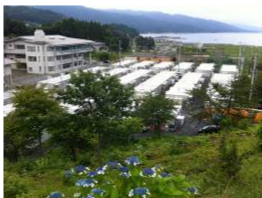
被害の無かった吉里吉里中学校も、運動場には仮設住宅が建ち並んでいます。
