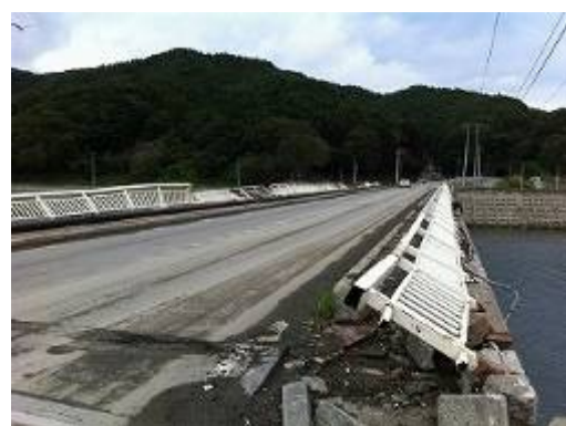
(写真②) 大槌川に架かる橋 写真右側から津波が押し寄せ手摺が倒れていた。
