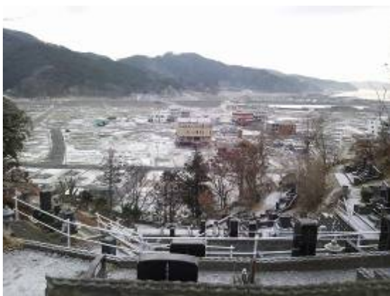
(写真①) 城山体育館から見た大槌町の市街地。 未だに被災建物が解体されず残っている。
