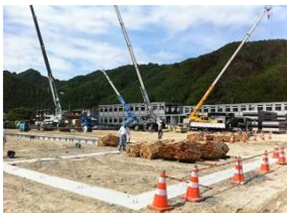
(写真⑯) 建設中の仮設校舎
