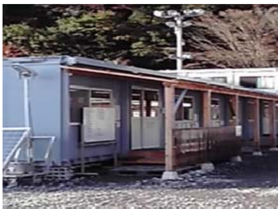
町民課の仮設庁舎
