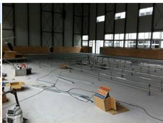
(写真⑰) 建設中の体育館 床の組み立てが進む
