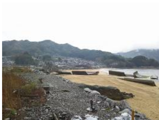
(写真④)吉里吉里地区の海岸。防波堤は各所で破壊され、引き波により海側になぎ倒されている。
