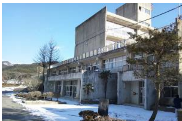
(写真⑨) 大槌中学校。災害廃棄物処理事業により今年度内に解体される予定。
