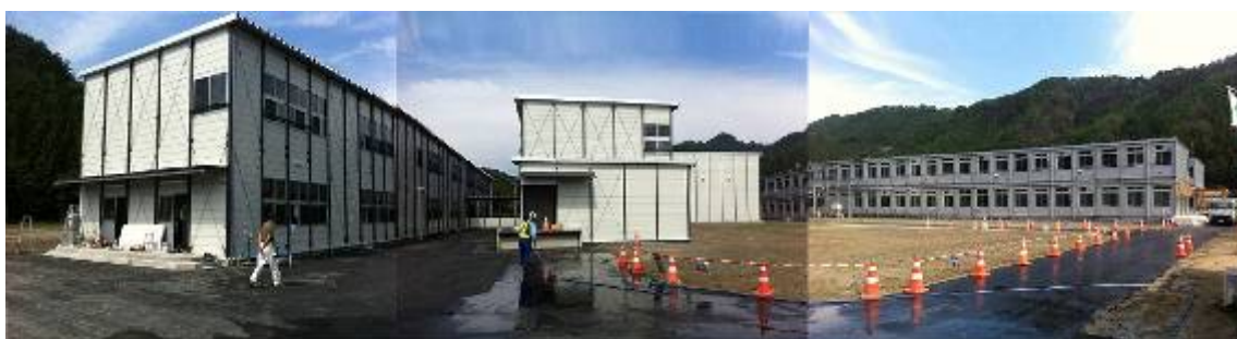
(写真⑬) 仮設校舎全景 右側が小学校棟、中央と左側は中学校棟
