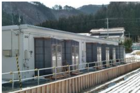
仮設住宅外観
