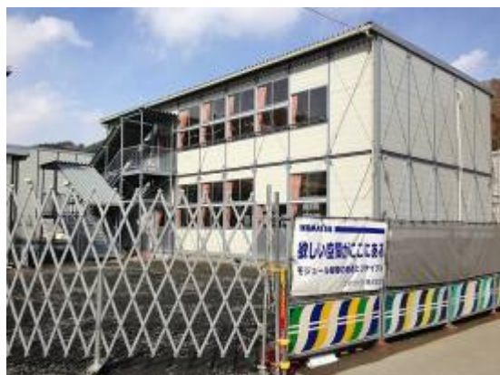
増築工事中の仮設校舎 (民間企業からのご支援)
