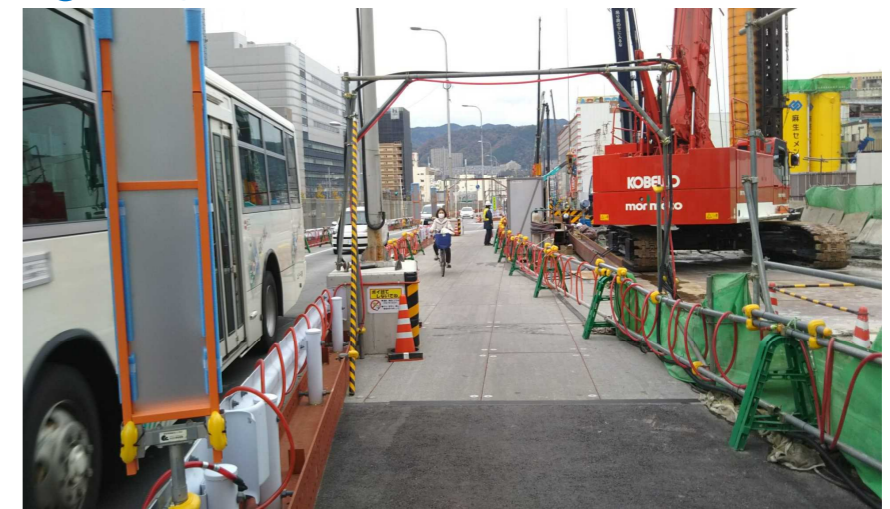
B ~ C 地下区間・(仮称)箕面船場駅／徒歩移動
