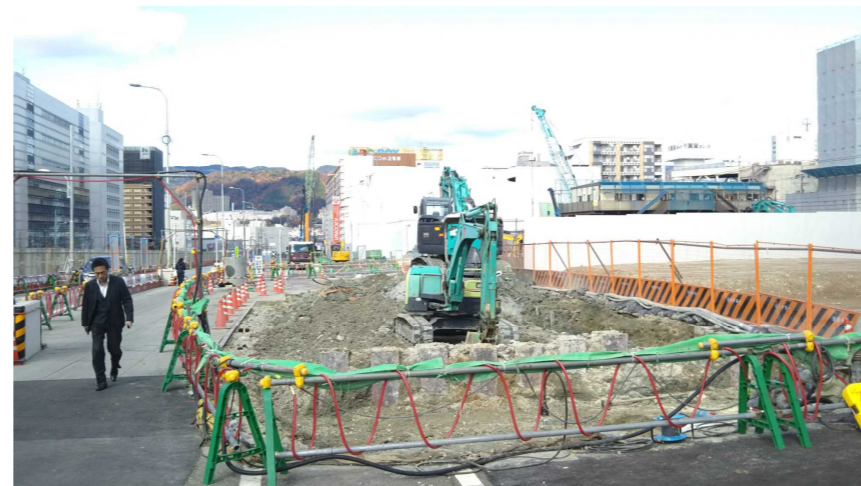
B 地下区間・(仮称)箕面船場駅／視察箇所(掘削工)
