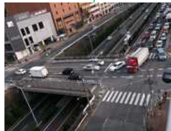
新船場南橋交差点の状況
