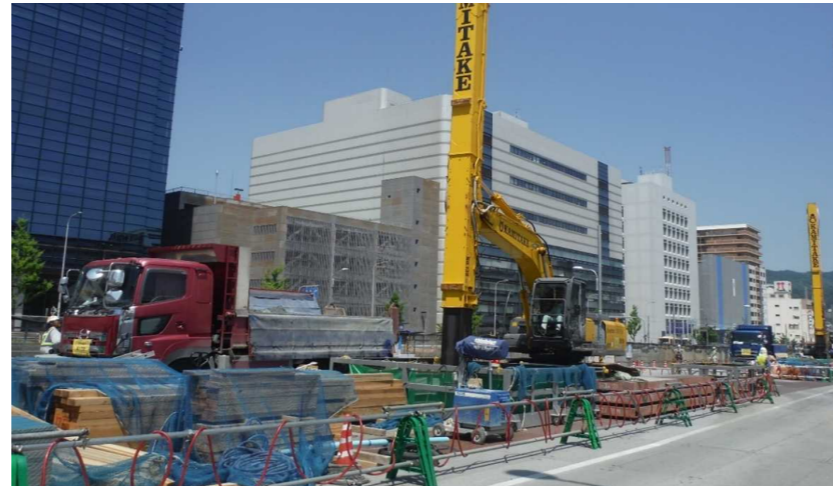
B 開削区間・箕面船場阪大前駅／視察箇所(地上)
