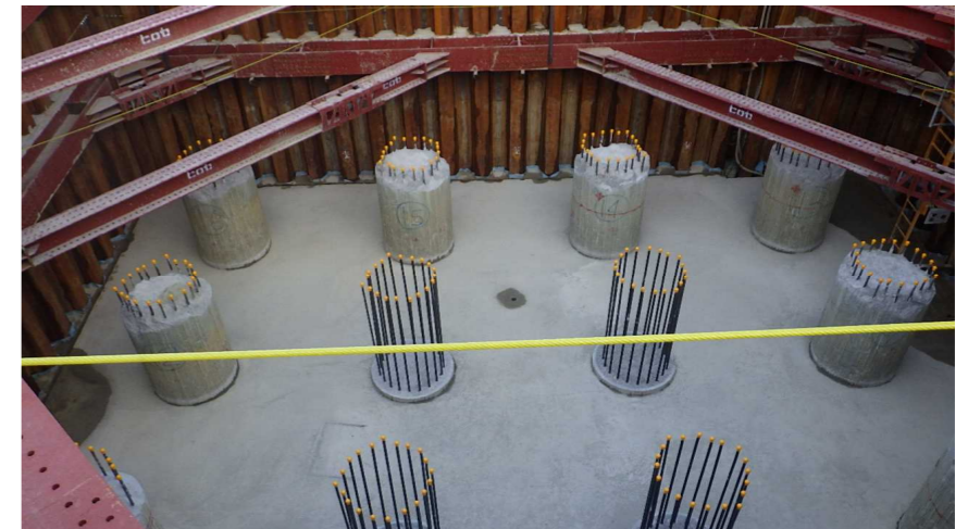
F 高架区間・箕面萱野駅／視察箇所(床付け)
