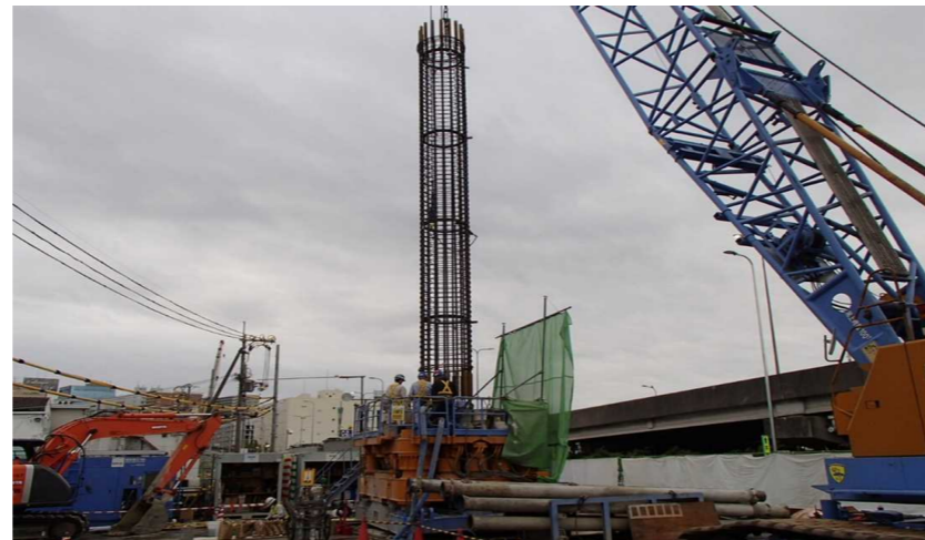
E 高架区間・箕面萱野駅／視察箇所(場所打ち杭工)
