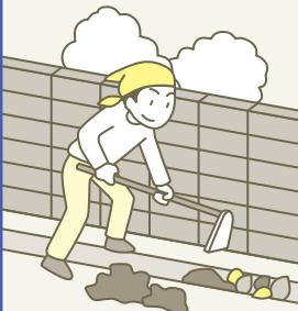
側溝にごみや落ち葉、木の枝などが詰まっていると、水が流れずあふれ出し、冠水の原因になります。1ヵ所の詰まりが周囲の冠水を引き起こし、自分の家の周りだけでなく、地域全体に大きな被害をもたらします。
