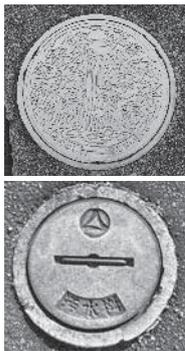
プラスチック製 コンクリート製
