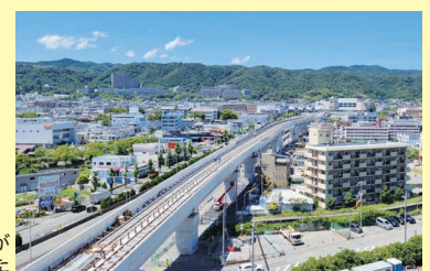
8月末に全ての高架橋が完成しました
