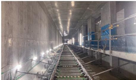
鉄筋コンクリートの構造物がほぼ完成し、軌道工事を行っている箕面船場阪大前駅ホーム階(地下3階)
