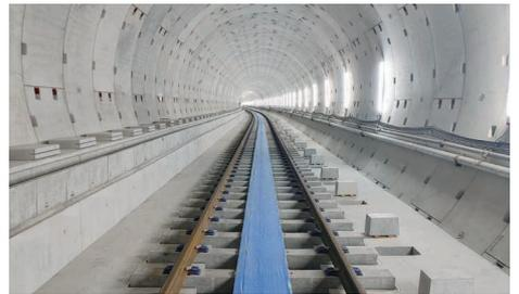
レール(軌道)の敷設を終え、電気工事が始まっているシールドトンネル内
