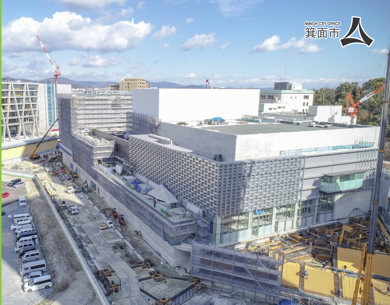
外装の工事をほぼ終えた複合公共施設(船場東3丁目)
