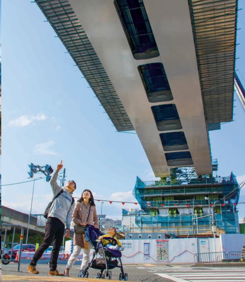
北急延伸線の高架橋が国道171号の上空に架かりました
