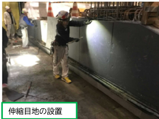
図 2.3.4 目地材:ポリエチレン樹脂発泡体目地板「セーフタイト」
