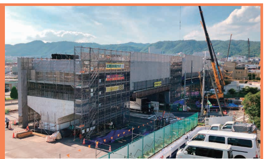
地面に埋めた基礎杭の上に橋脚をつくっています。
