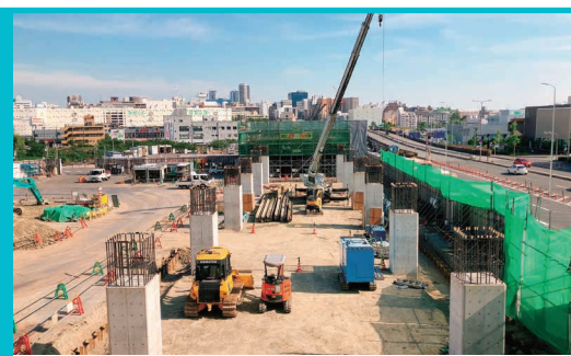
箕面萱野駅の駅舎の土木工事を進めています。
