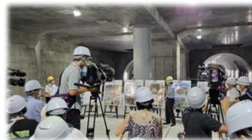
令和4年8月25日 箕面船場阪大前駅 報道公開の様子
