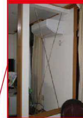
露出仕上げ 部屋を広く見せるため、柱と筋交いを露出した補強を行いました。
