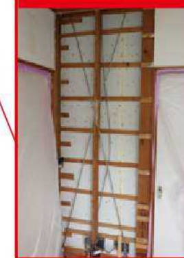
ステンレス製補強金物 壁をステンレス製補強金物で補強しました。
