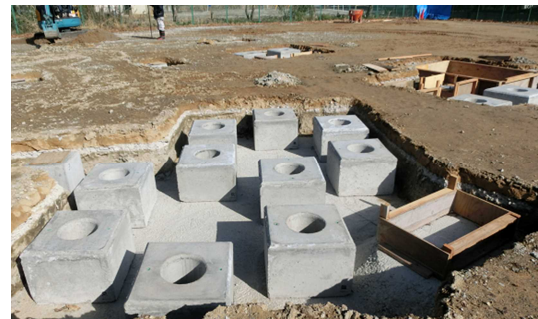
写真一 2 多機能遊具基礎
