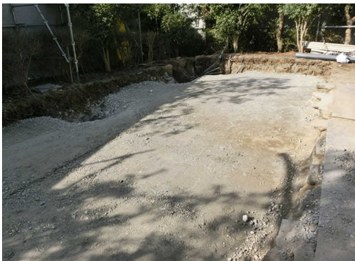
写真－１ 基礎クラッシャーラン敷均し状況
