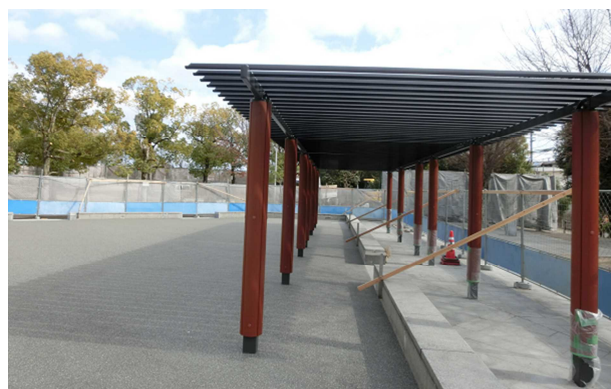
写真一 4 多世代エリア パーゴラ及び 遮熱ゴムチップ舗装
