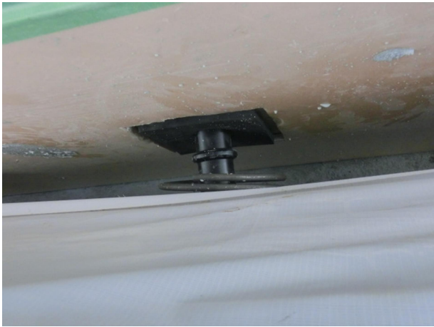
アンカーバー設置状況
