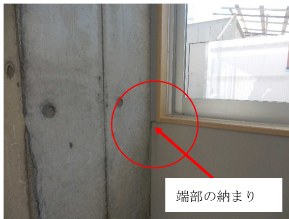
写真1：1階事務室コーキングの納まり
