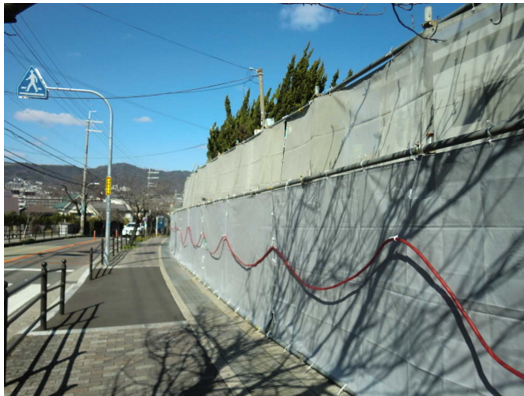
市立霊園 仮設ネットフェンス
