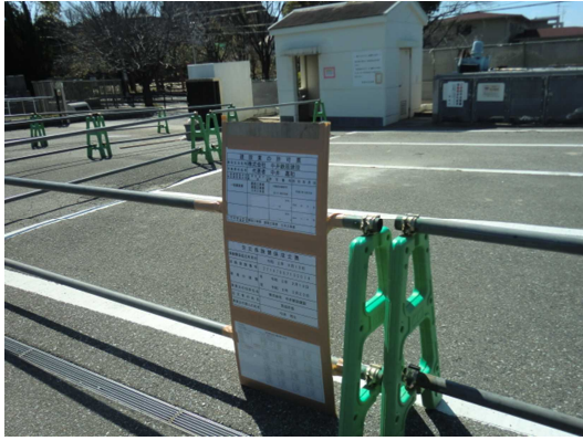
市立霊園 工事看板設置状況
