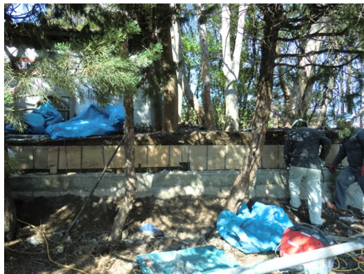
旧し尿中継所 コンクリート塀打設前状況
