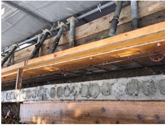
市立霊園 フェンス基礎配筋状況
