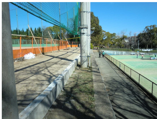
市民野球場 ブロック塀撤去状況
