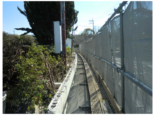
市立霊園 ブロック塀撤去後状況
