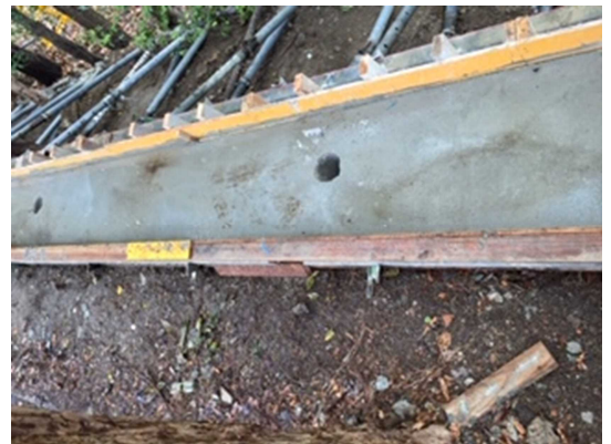
旧し尿中継所 保護コンクリート打設後状況
