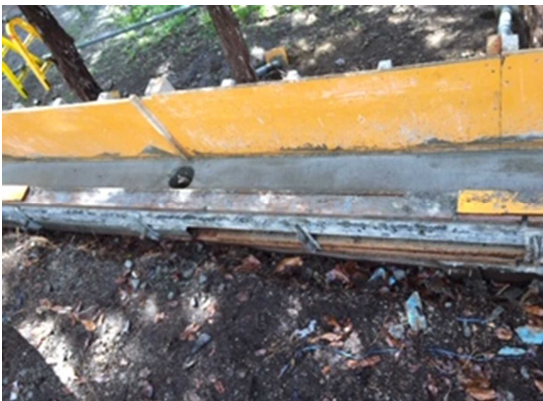
旧し尿中継所 コンクリート塀打設後状況
