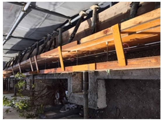
市立霊園 フェンス基礎型枠設置状況
