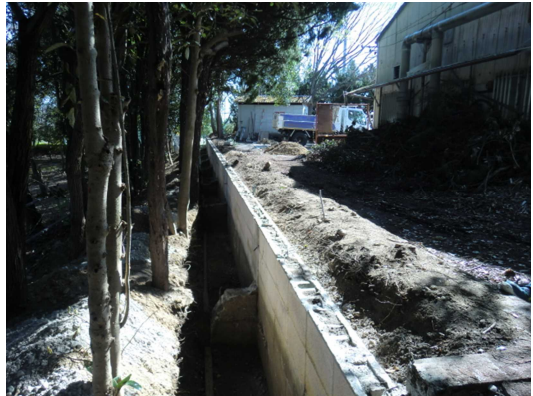
旧し尿中継所 ブロック塀撤去後状況
