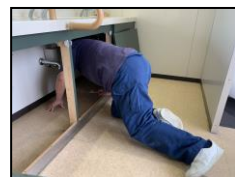
トイレの手洗い場を 修理中の北室さん
