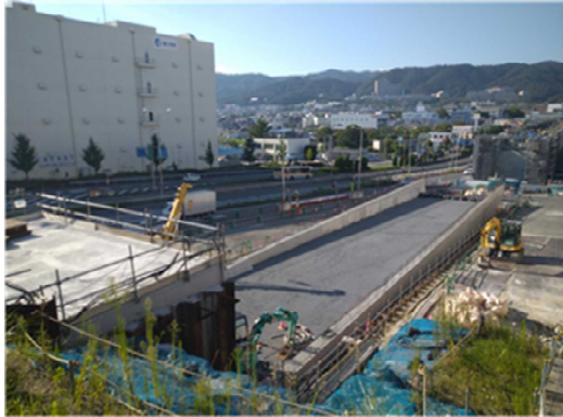
【COM1号館西側躯体構造】
