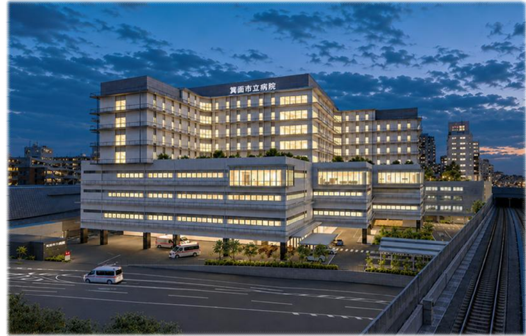
○外観イメージ（北側より、夜間）
