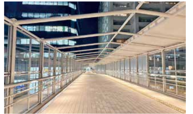
※新御堂筋をまたぐ歩行者デッキが完成し、船場西地区の新船場西公園から、船場東地区の複合公共施設まで通行が可能になりました。
