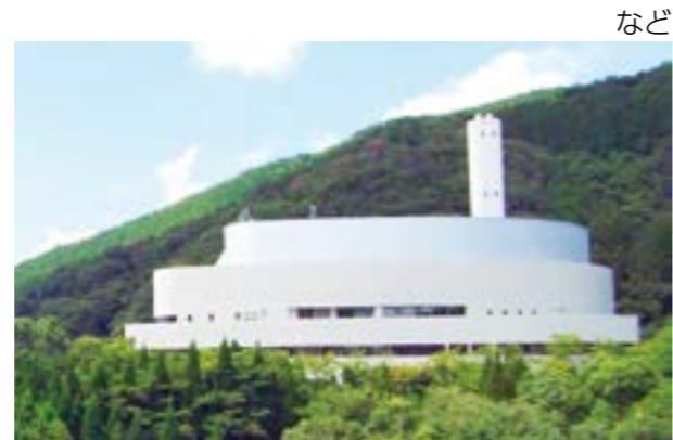
※操業開始から25年が経過した環境クリーンセンターの改修・延命工事を行い、施設の維持管理・運営を包括的に委託します。
