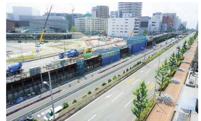
※歩行者デッキの整備など、工事が進む箕面船場阪大前駅前地区。
