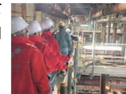
北大阪急行線延伸工事を視察
