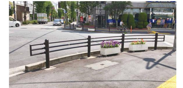
※車両が歩道へ進入しないように、市が管理する信号のある全交差点へガードパイプ・門型車止め・ポールのいずれかの設置を予定しています。
