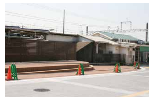
※ステージなどを備えた、にぎわいと活気にあふれた魅力あふれる阪急桜井駅周辺をめざして、再整備を行っています。
