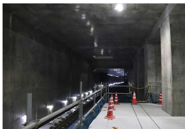
所感：駅舎北口のCOM2号館から、地下3階まで階段で降り、200mあるプラットホーム上で説明を聞きました。地下3階では白っぽい「もや」のようなものがかかっており、聞くと、現在は換気をしていないため湿気があり、少し「もやっている」とのことでした。線路は、新品でも鉄部分は酸化しているようでしたが、電車が走り出せばきれいになるのでしょう。階段とエスカレーターは横並びではなく縦並びとなるようで、階段の幅は工事のためもあるのか少し狭く感じられました。南出口のエスカレーターなどはまだ見ることはできませんでしたが、プラットホームにタイルを敷くなど、今後はトンネルの内装などにも着手するとのことでした。完成までにまた視察したいと感じました。
