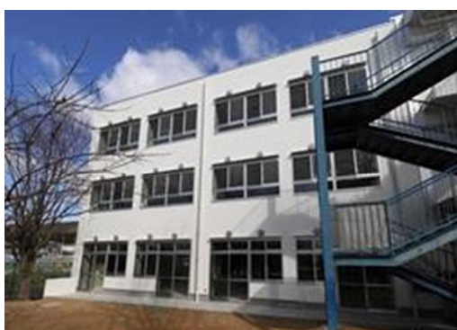
萱野東小増築棟 南側外観
