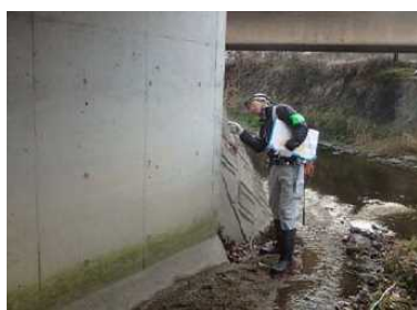
写真 1.1 近接目視による点検状況
