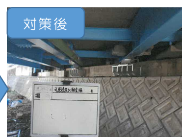
写真 1.2 修繕工事に合わせ実施した耐震対策
