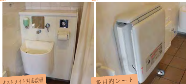
オストメイト対応設備
