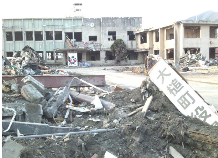
〈被災した大槌町役場〉
