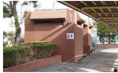
現況トイレ外壁
