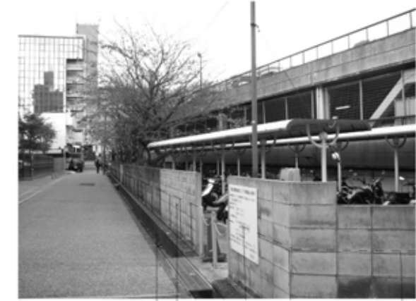
ブロック壁を撤去し、デザインフェンスに変更 側溝 (グレーチング設置)
