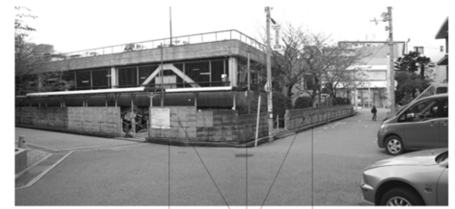
側溝 (グレーチング設置) ブロック壁を撤去し、デザインフェンスに変更 側溝 (グレーチング設置)
